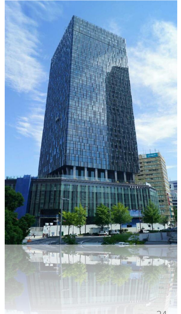
大名古屋ビルヂング
