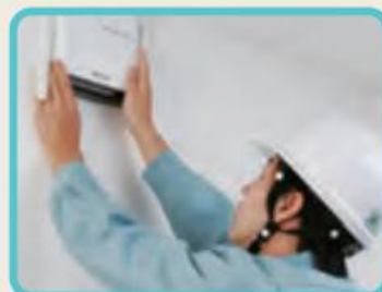
設定・設置・工事
