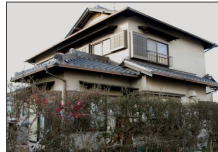
第1号の住宅建設
