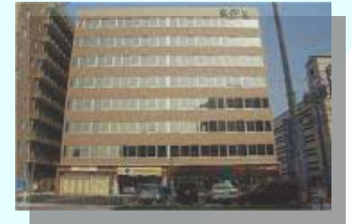
テナントビル「東祥ビル」 2棟
