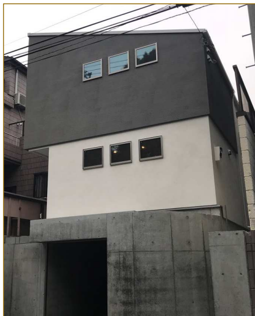
世田谷区弦巻の施工事例
