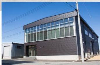
コンセプトセンター 長野県飯田市 (鋳造事業、CT事業)
