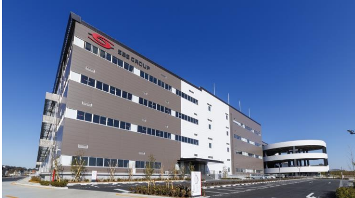
野田瀬戸物流センターA棟
