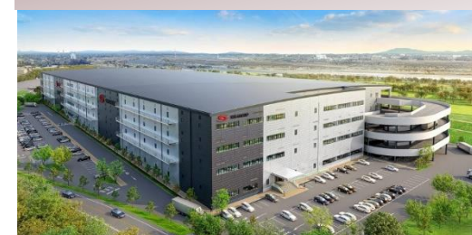
野田瀬戸物流センターA棟 24年1月竣工(予定)
