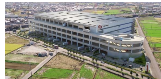
物流センター一宮(仮称) 23年4月竣工(予定)
