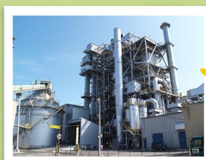
燃焼・発電 （バイオマス発電所）
