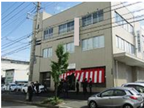
テクニカルセンター 外観
