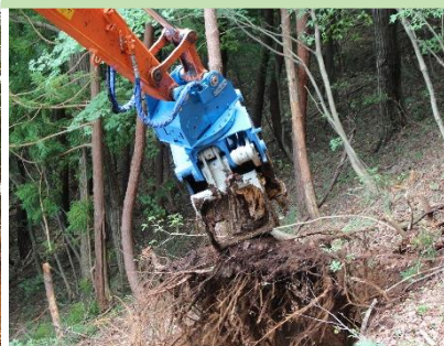
【除根・埋め戻し】
