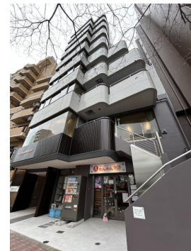
1棟事務所（文京区）
