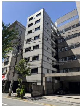
1 棟事務所（千代田区）
