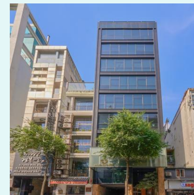
Totech Vietnam Solutions Co., Ltd. ホーチミン事務所(7階)
